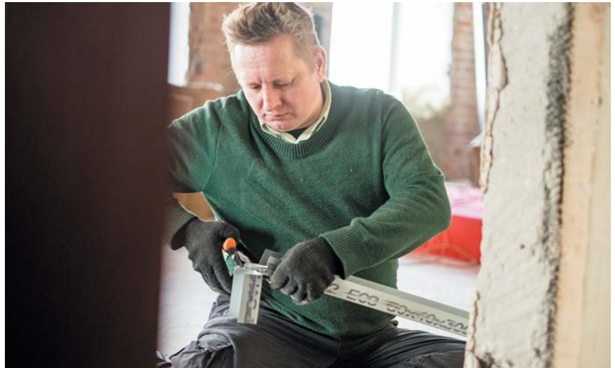
Сотрудники Leroy Merlin самостоятельно помогают ремонтировать здания детских домов
