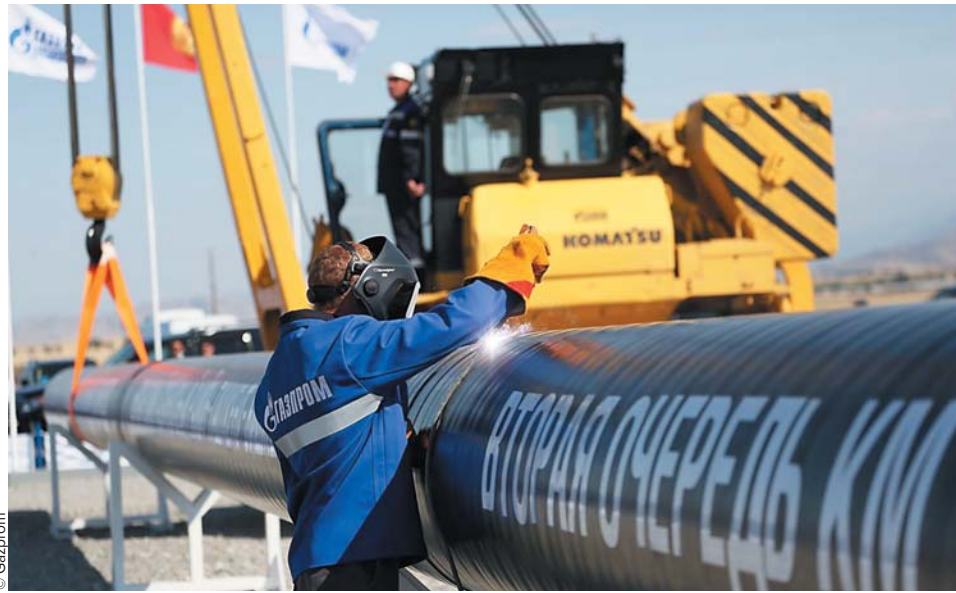
Construction d'un gazoduc
