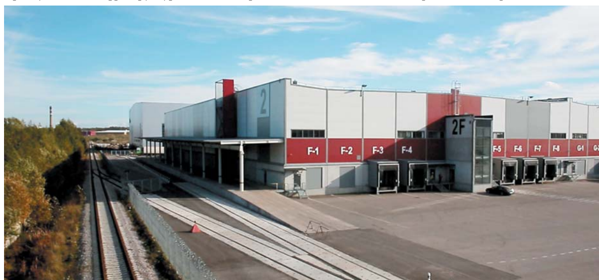
Собственная ветка железной дороги проходит по северной границе индустриального парка Greenstate
