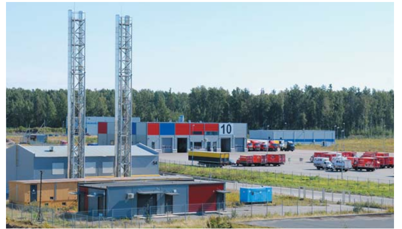
В центральной части индустриального парка находится инженерный блок с мощной котельной, трансформаторной подстанцией и резервуарами пожарной воды
